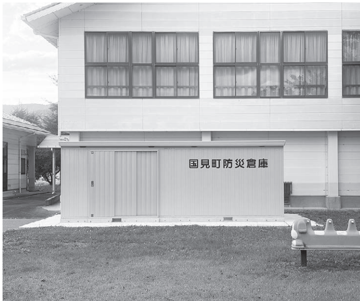
増設した大枝地区の防災倉庫
