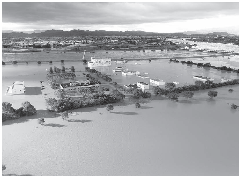
令和元年水害で被災した県北浄化センター
