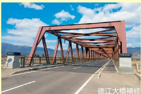
徳江大橋補修
