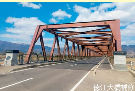
徳江大橋補修
