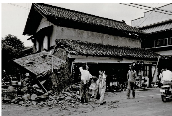
宮城県沖地震で倒壊した家屋
