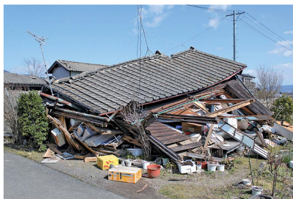
東日本大震災で倒壊した家屋
