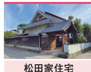
松田家住宅 ※一般住宅のため敷地内への立ち入りはご遠慮ください。
