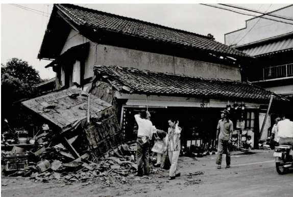
宮城県沖地震で倒壊した家屋
