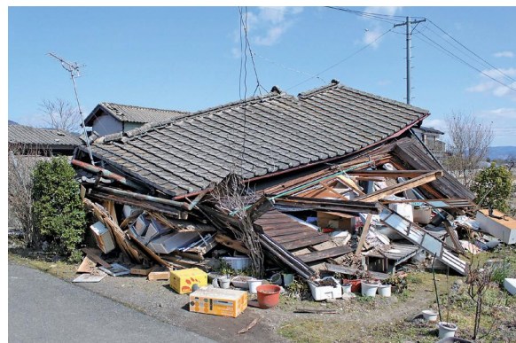
東日本大震災で倒壊した家屋
