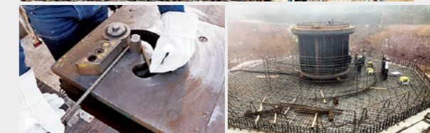
▲工場で1本1本鉄筋を加工する ▲吾妻高原風力発電所の基礎工事の様子
