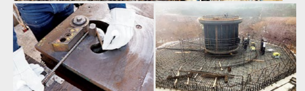
▲工場で1本1本鉄筋を加工する ▲吾妻高原風力発電所の基礎工事の様子
