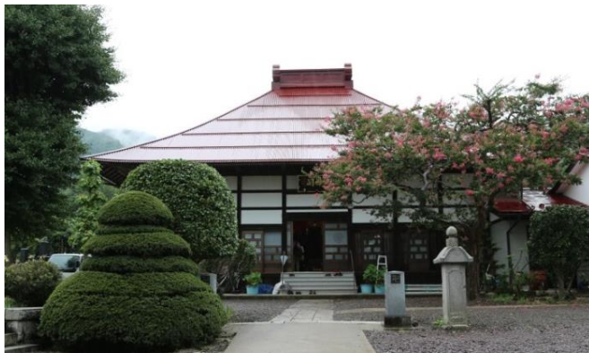
■明和2年(1765)建築の最禅寺本堂
