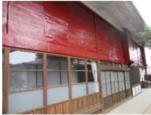
■鉄板の雨戸（2階部分）
