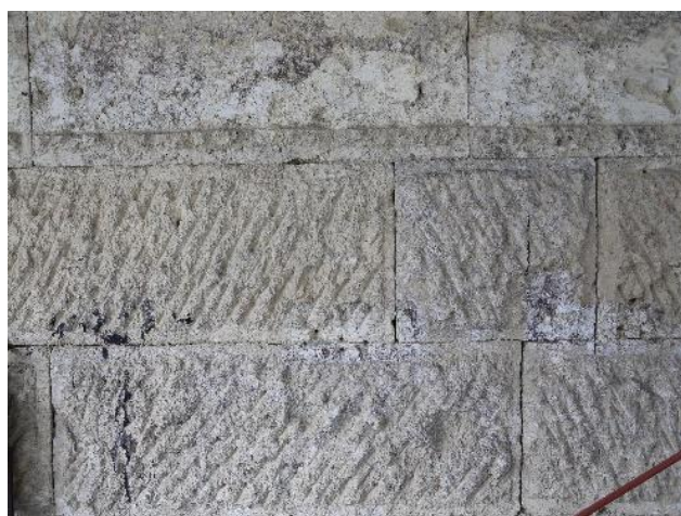
■ 目地にモルタルを用いず隙間がない特徴的な積み方
