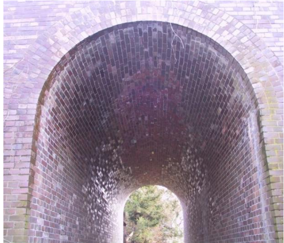
■レンガ積みのヴォールト天井
