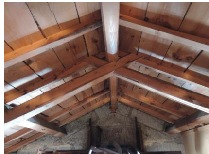
■石蔵屋根内部
