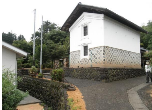
■海鼠壁を持つ漆喰の土蔵
