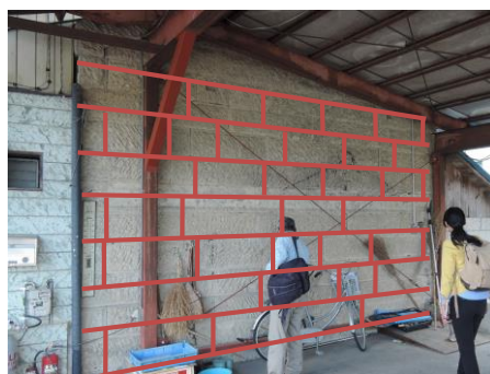
■「壁面目地」表面状況。
