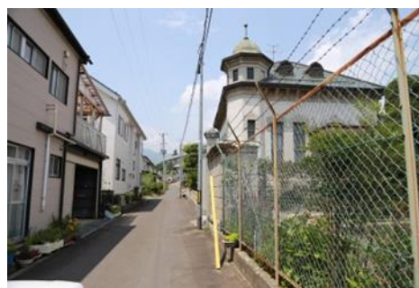
■旧奥州街道藤田宿の奥山家住宅 旧宿場町の中心にある奥山家住宅は、電柱等により景観が損なわれている。
