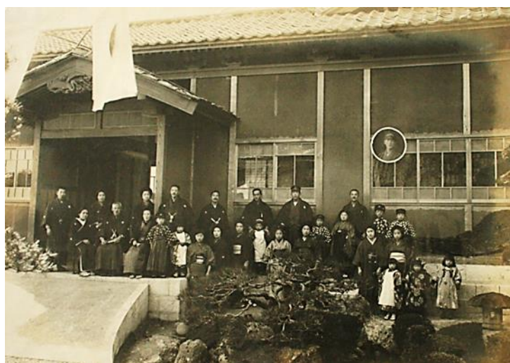
■竣工間近の奥山家住宅 大正9年（1920）
