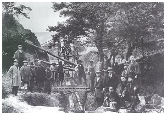
■観月台ため池修繕工事 昭和4年（1929）
