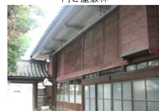
鉄板の雨戸(2階部分)
