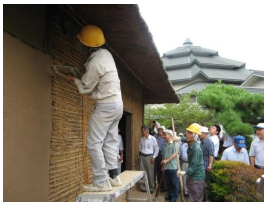
■土壁の修繕作業
