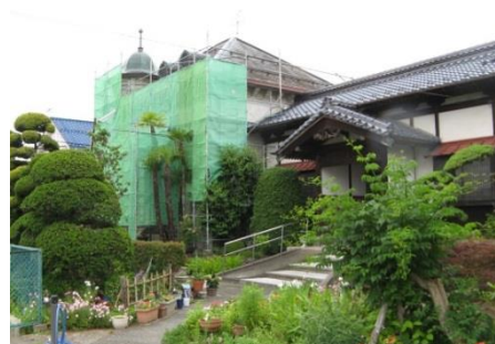
■奥山家住宅洋館 災害による修繕
