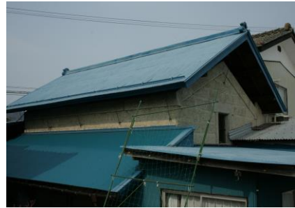
■伊藤家石蔵（大正6年(1917)建築）
