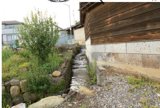
水路と板塀・石塀
