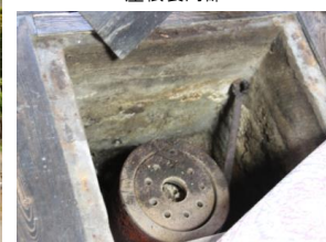
板の間の下に設けられた暖房器具入れ
