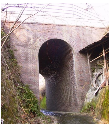
■貝田姥神沢旧鉄道レンガ橋
