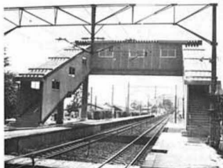
▲りっぱに完成したこ線橋
