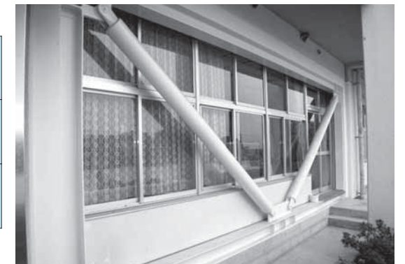
補強工事が施された藤田小の校舎
