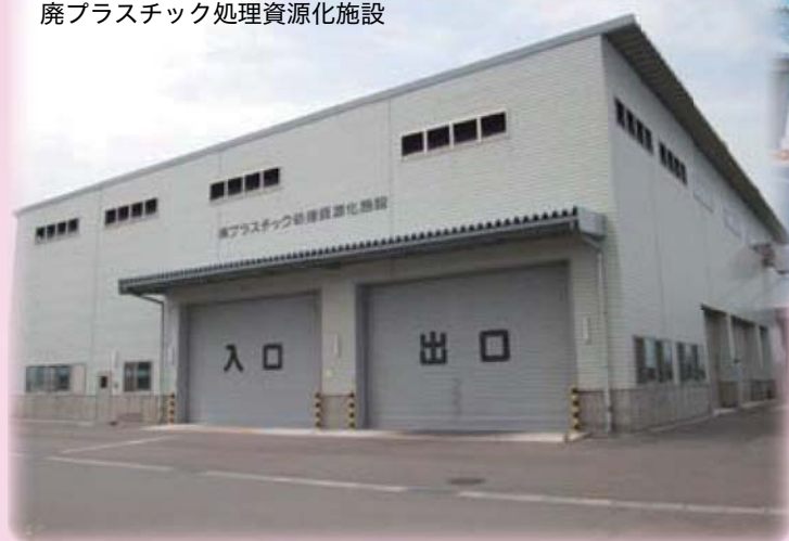
廃プラスチック処理資源化施設
